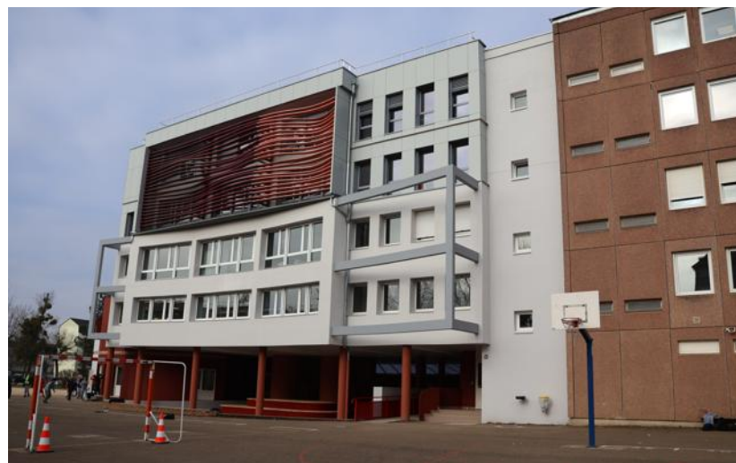
L'extension du collège Saint-Joseph – La Salle a consisté à surélever le bâtiment en photo de deux étages supplémentaires. Photo N. D.
